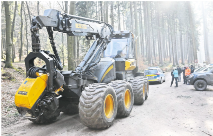
Begleitet von einem großen Polizeieinsatz und dem Protest der Windkraftgegner begannen gestern die Rodungsarbeiten für den geplanten Windpark im Gebiet „Stillfüssel“ bei Wald-Michelbach. BILD: FRITZ KOPETZKY
